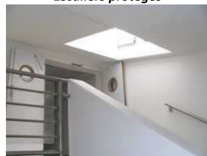
Commande de désenfumage et exutoire de fumées Escaliers protégés
