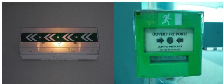
**Balisage des cheminements - Déclencheur manuel de déverrouillage**
