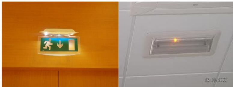
**Bloc d'éclairage de sécurité d'évacuation (sortie) / Bloc d'éclairage de sécurité d'ambiance (locaux)**
